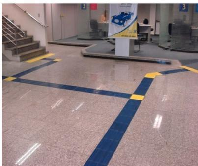
Figura 11 – Piso Tátil que facilita a locomoção do deficiente visual (Bersch, 2005)
