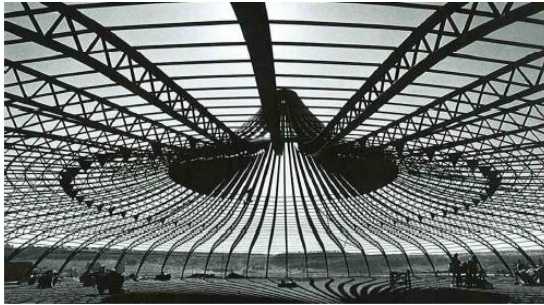
FIGURA 2 - Estrutura do ginásio
