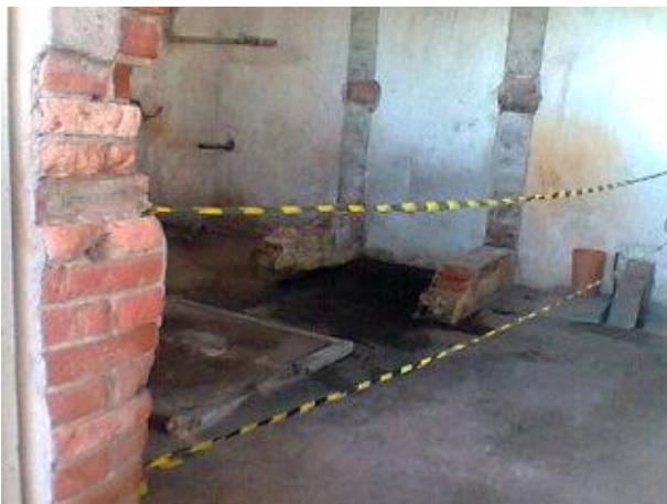
FIGURA 17 – Antiga caldeira sem a presença de entulhos Fonte: Luciane Müller (2014)
