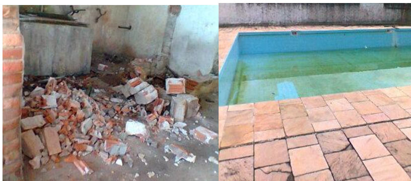
FIGURA 14 e 15 – Entulhos da antiga caldeira e piscina
