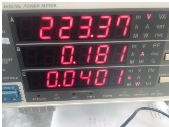
Figura 22 - Medição do ventilador com o wattímetro
