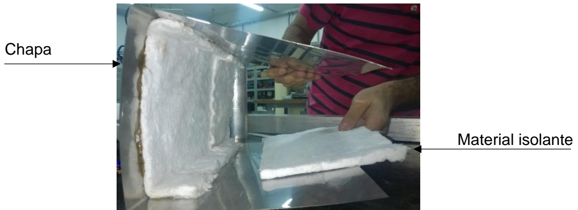
Figura 44 – Fixação das placas de lã de rocha
