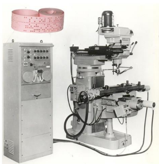
Figura 1 - Fresadora vertical comandada por Controle Numérico (CN) Fonte: Protoptimus [11].
